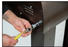
**4.** Avvitare il tubo flessibile al forno e aiutarsi con una chiave apposita per il perfetto serraggio.
